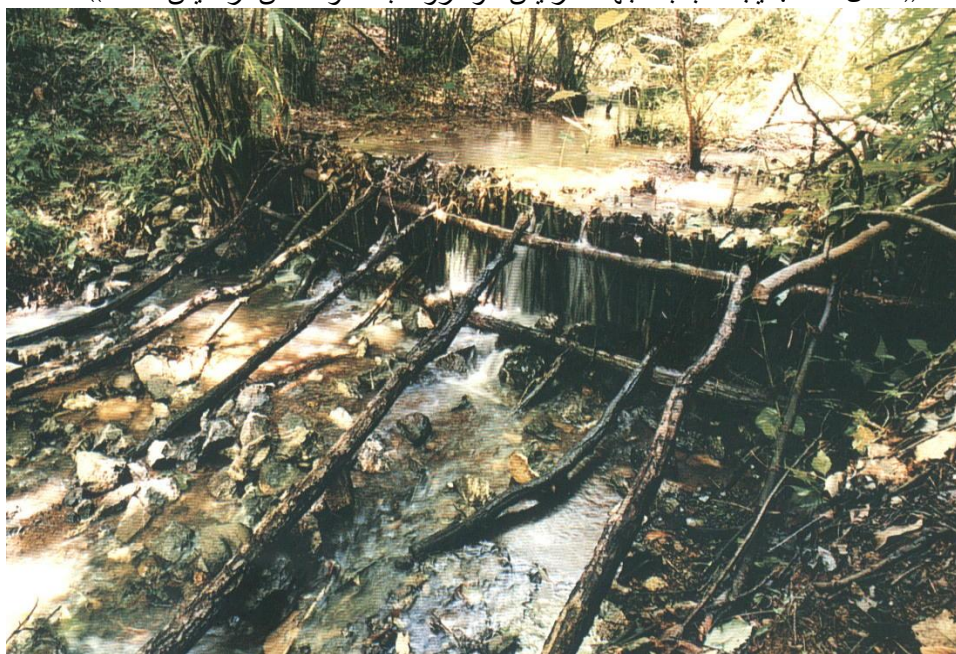
« شکل ۴۲ : ایجاد آب بند جهت افزایش نفوذ رواناب ها و کاهش فرسایش خاک »
